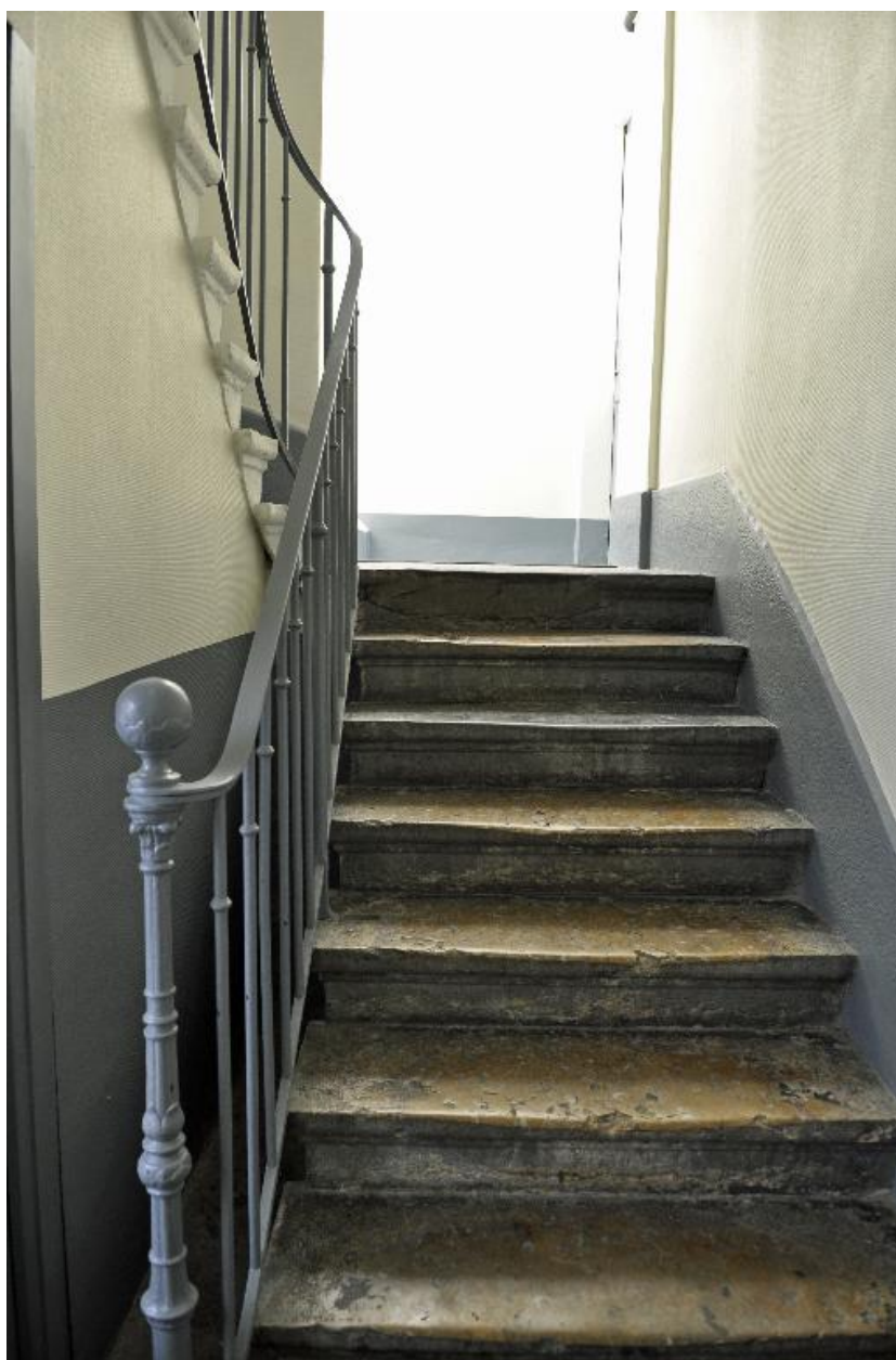
Vue intérieure : le départ de l'escalier
