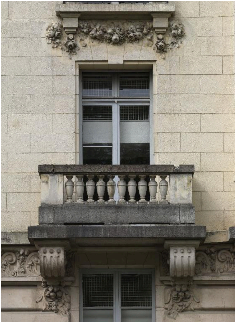
Façade sur cour: baie du 1er étage
