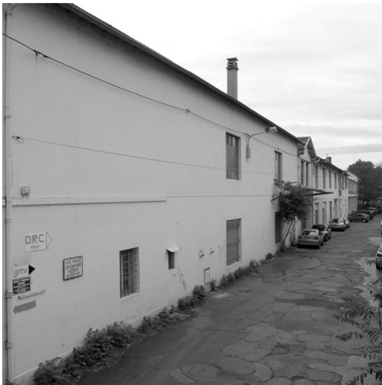
Vue d'ensemble façade ouest
