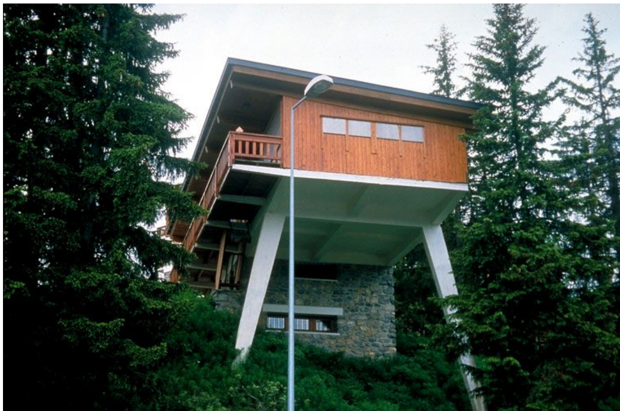
Vue depuis l'est-sud-est
