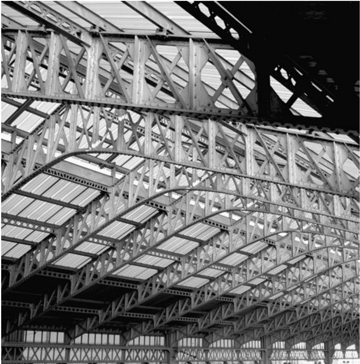
Halle Saint-Etienne : la charpente métallique
