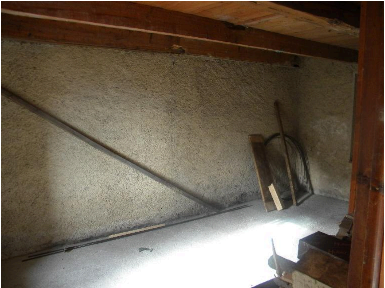
Vue de la salle arrière du bâtiment sud.
