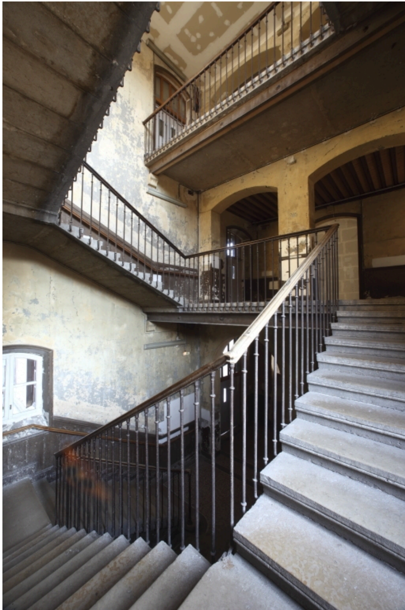
Escalier de desserte des niveaux supérieurs.
