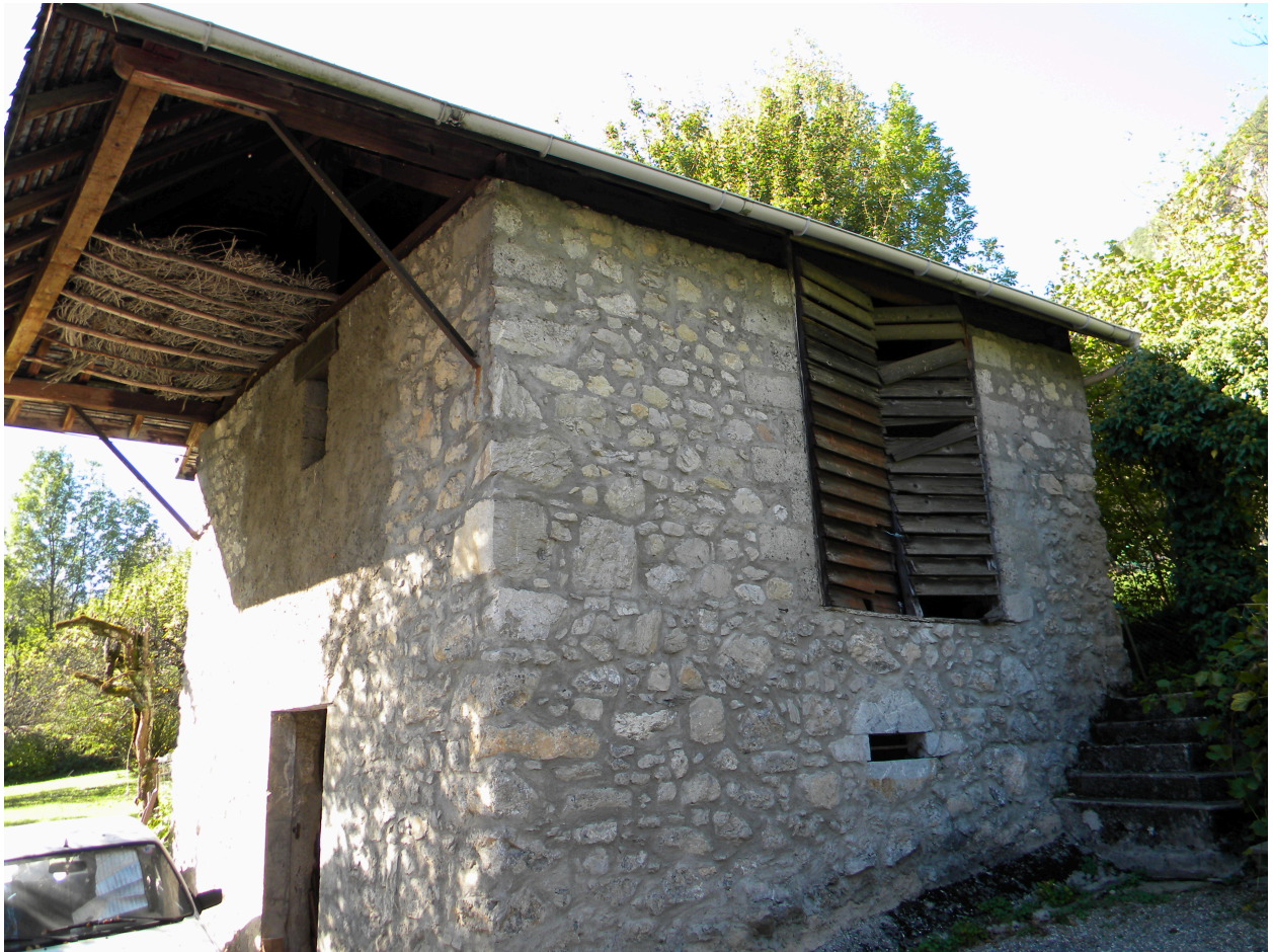
Vue de trois quarts depuis la cour.
