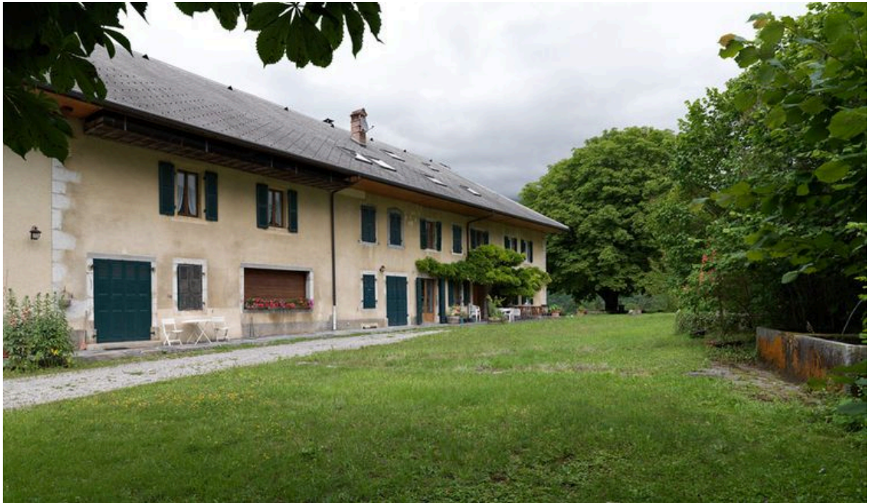
Vue de la cour avec le façade principale et le bassin privé lui faisant face.
