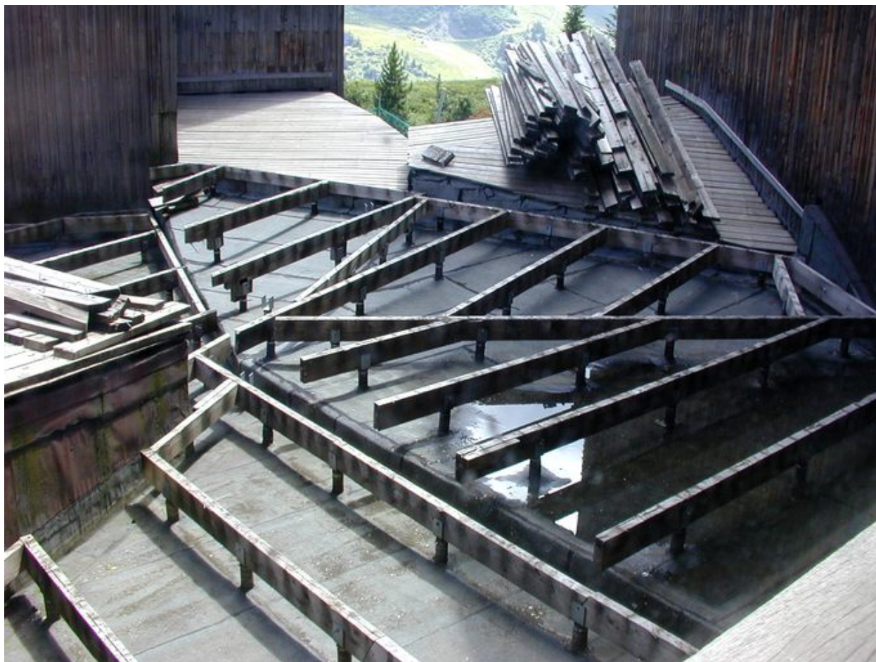
Détail de toiture
