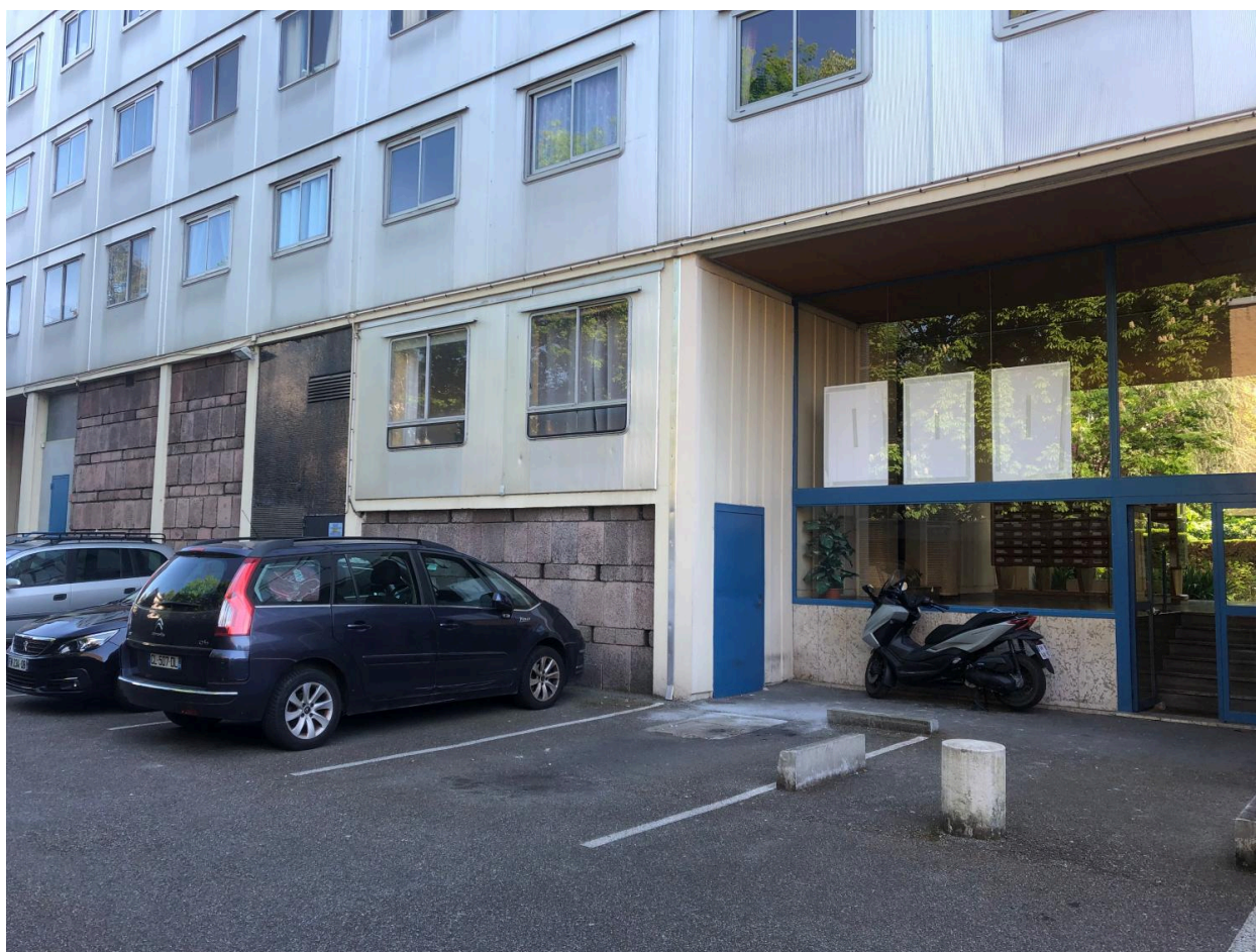
Façade nord, loge du gardien au rez-de-chaussée (2 baies)
