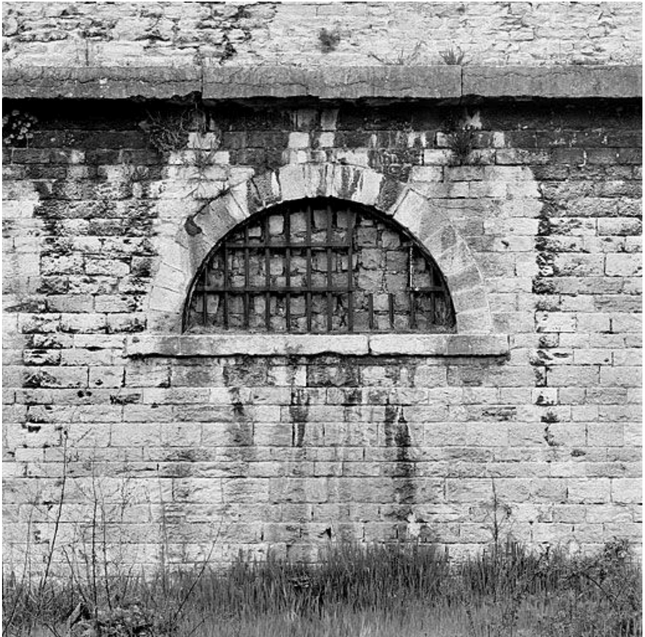
Ouverture de casemate murée 2
