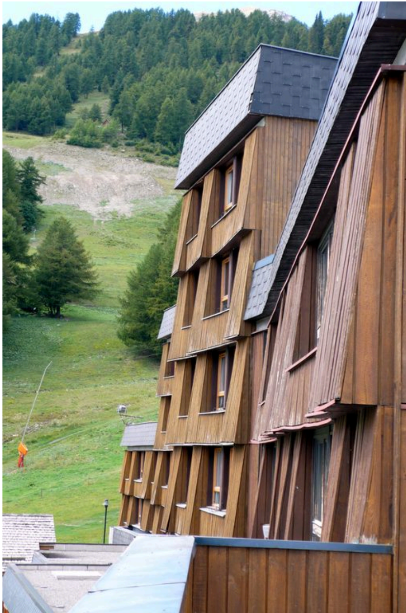
Détail de la structure de la façade
