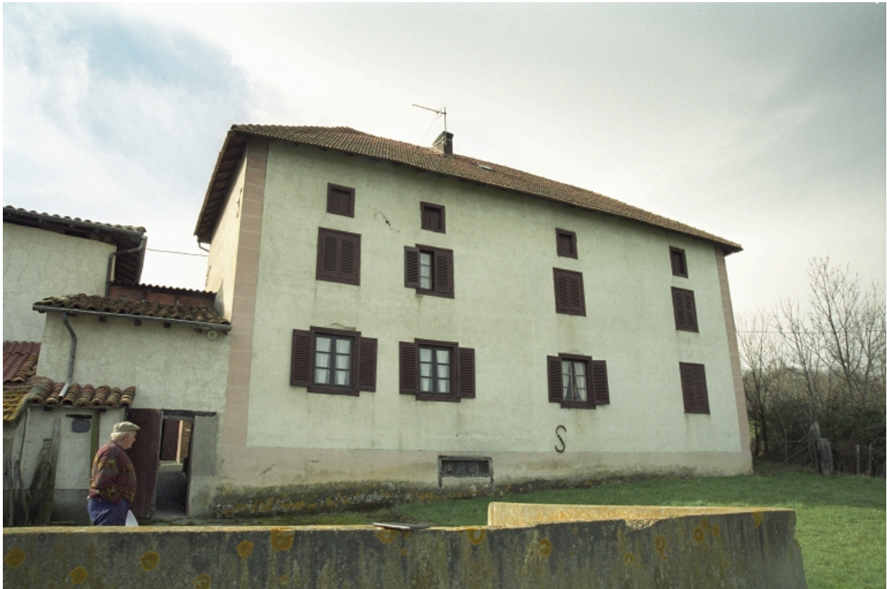
Trelins, Valézy (1986 B4 1383), type B1. Elévation postérieure du logis.
