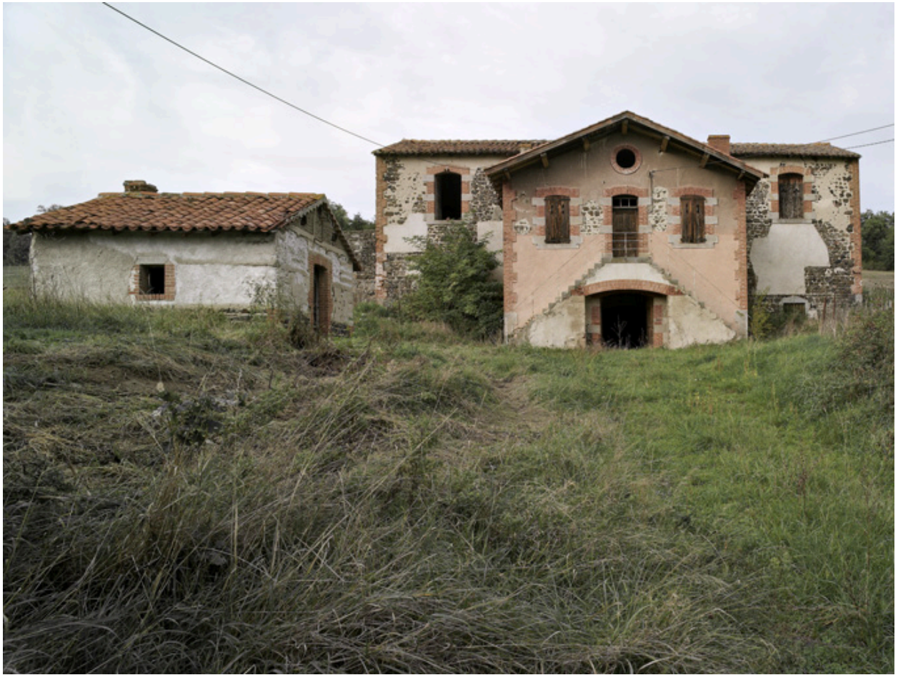
Vue d'ensemble de l'édifice principal et du fournil.
