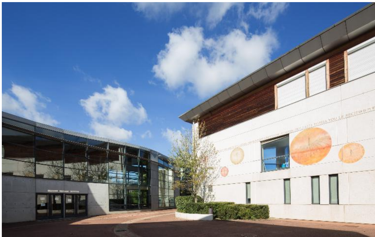
Bâtiment E avec 1% artistique et bâtiment A
