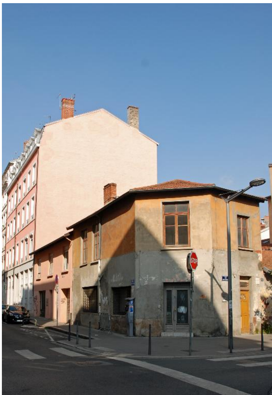
Vue de la maison d'angle
