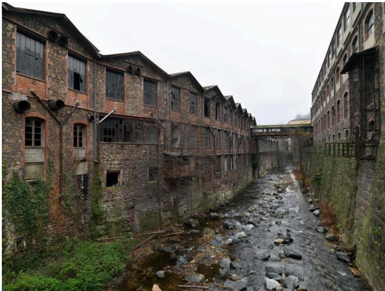
Vue des ateliers le long de la Cance.
