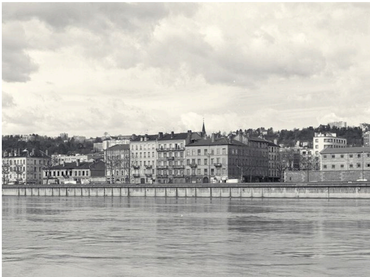
Vue d'ensemble depuis le nord-est, rive gauche du Rhône, entre le cours Suchet et la rue Marc-Antoine-Petit
