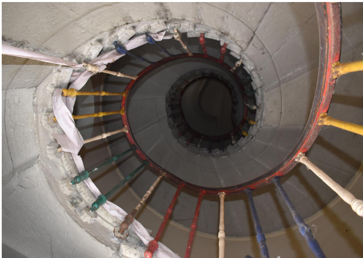
Escalier en vis dans la tour octogonale
