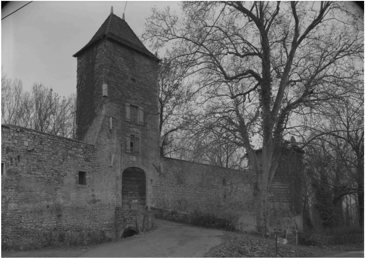
Tour-porche (ouvrage d'entrée), élévation nord.
