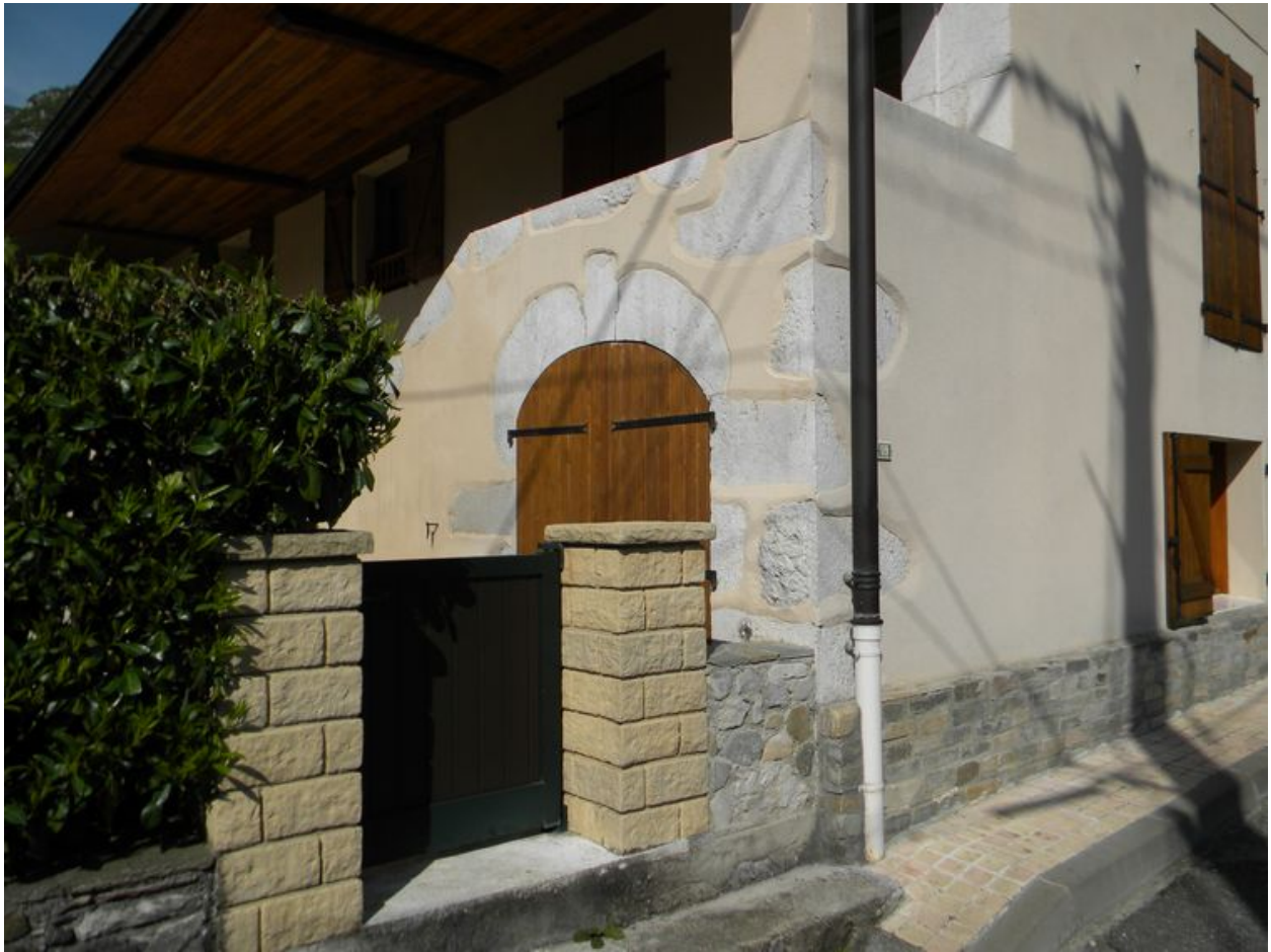
Entrée de cave sous escalier extérieur d'une ferme remaniée (2008 A3 3547).
