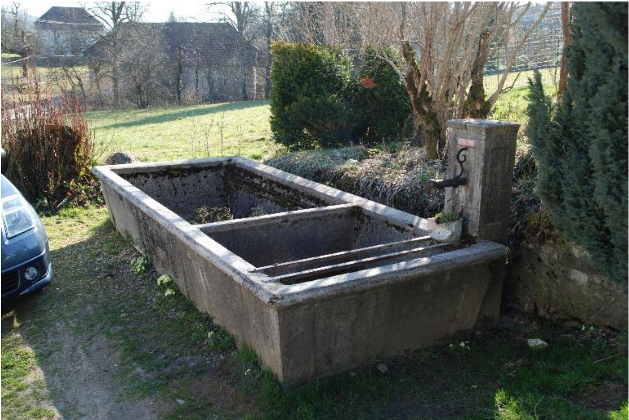
A3 266, Balevaz, bassin-lavoir. Vue d'ensemble du bassin daté 1905.
