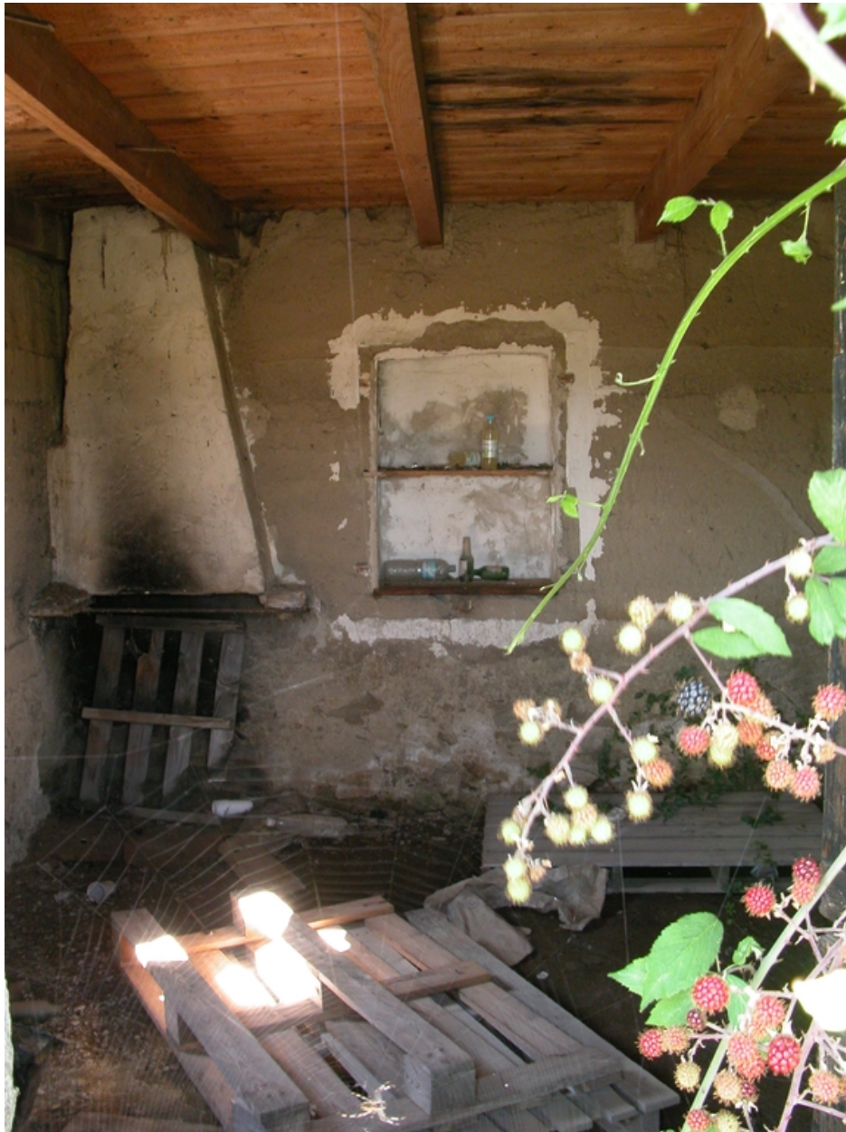
Vue intérieure du rez-de-chaussée (cheminée, placard).
