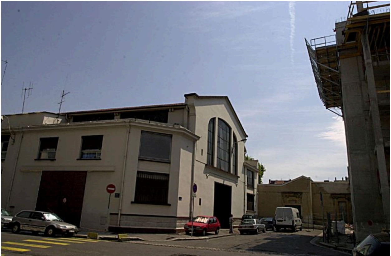
Vue de l'extrémité est de la rue Clair-Tisseur, se terminant en impasse contre le mur d'enceinte du groupe scolaire Jean-Pierre Veyet
