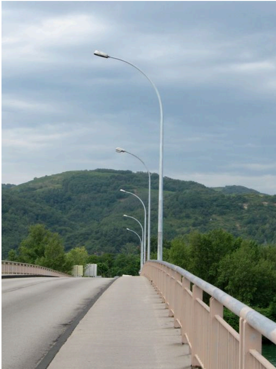
Vue partielle, de dessus, chaussée et parapet (depuis la rive gauche)
