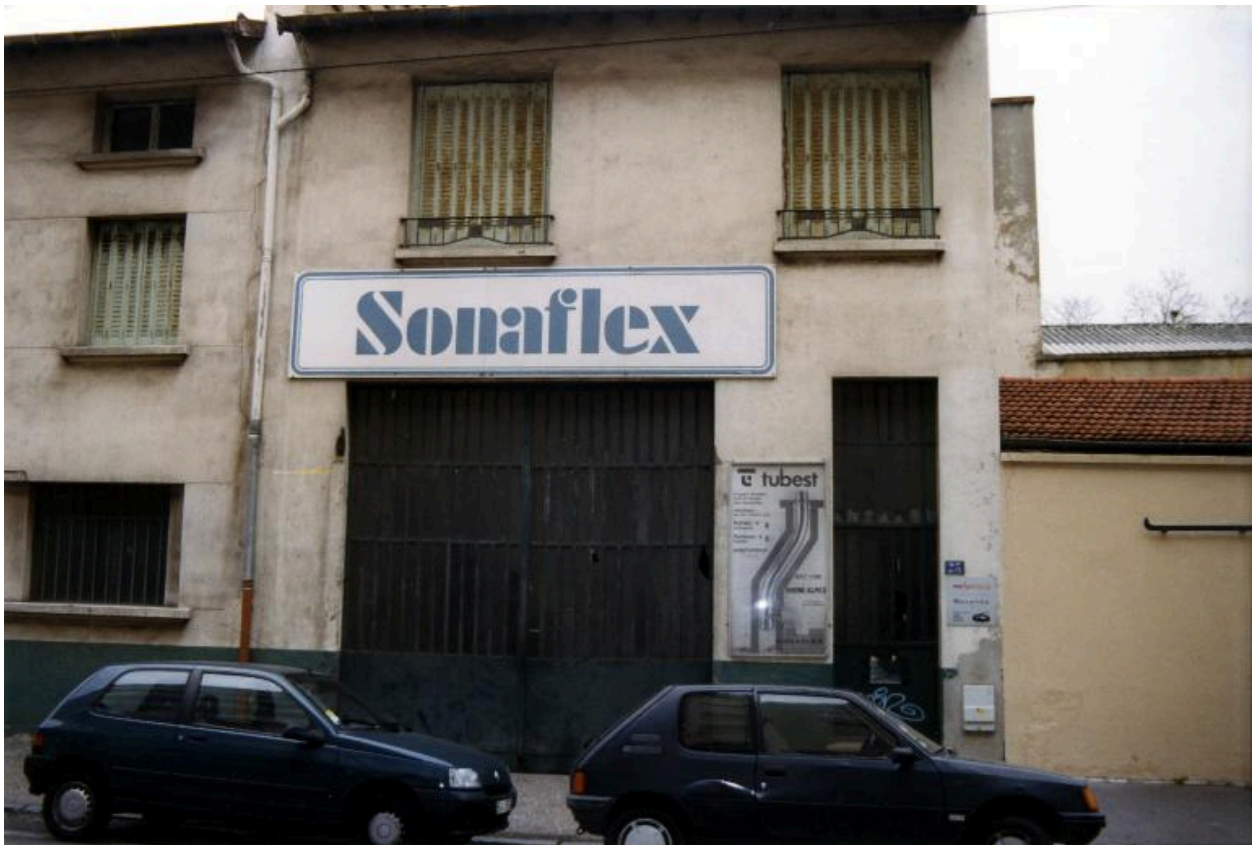
Ancienne maison-atelier, façade sur la rue Pierre-Robin
