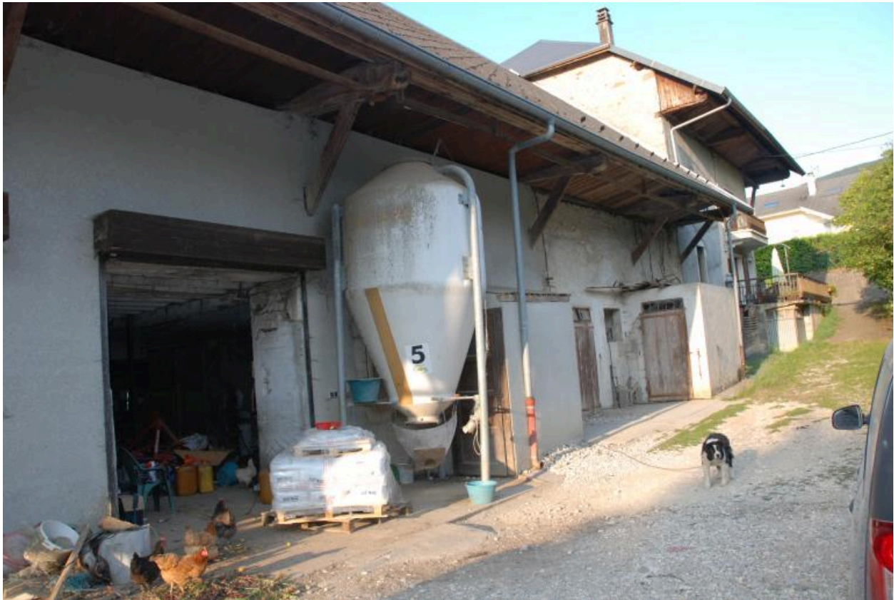
Vue d'ensemble de la façade sud sur cour.
