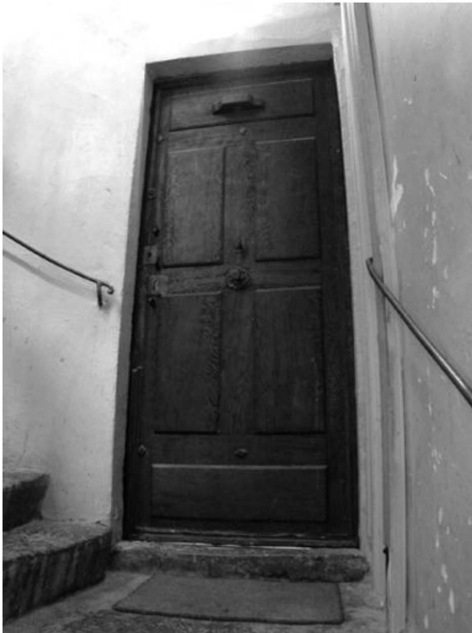
Escalier, porte palière du 3e étage
