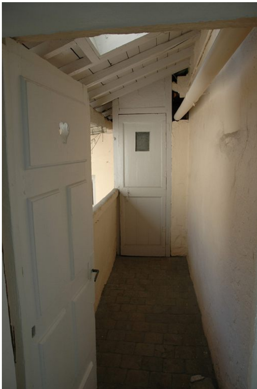
Couvent : 12 place Antonin-Gourju, galerie menant aux latrines de l'immeuble
