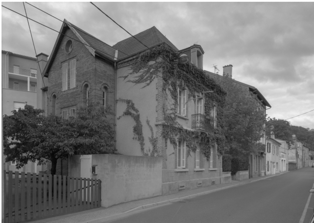
Boën, îlot 21, 8 Mai 1945 (rue du) 8. Vue générale de la façade sur rue, depuis l'ouest.
