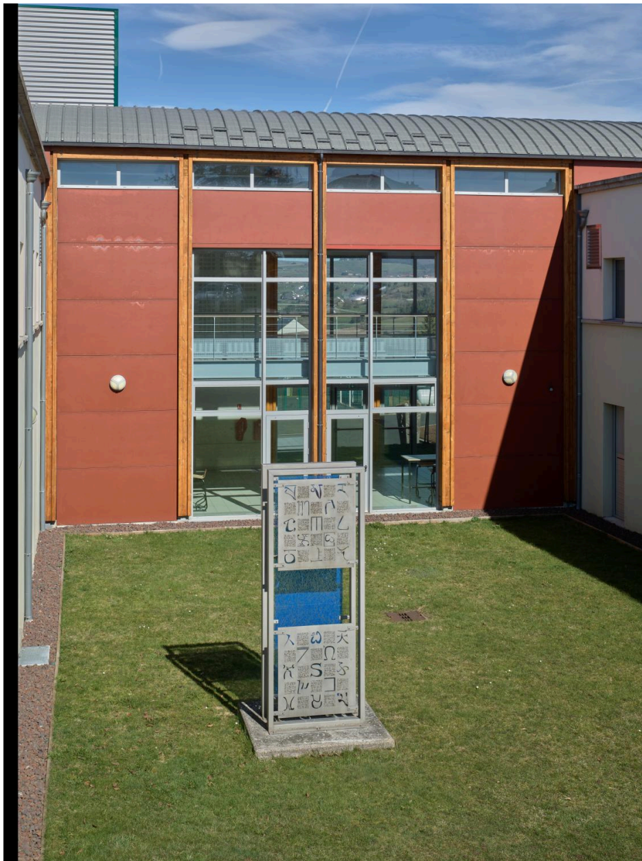
Installation n°2, autre vue d'ensemble
