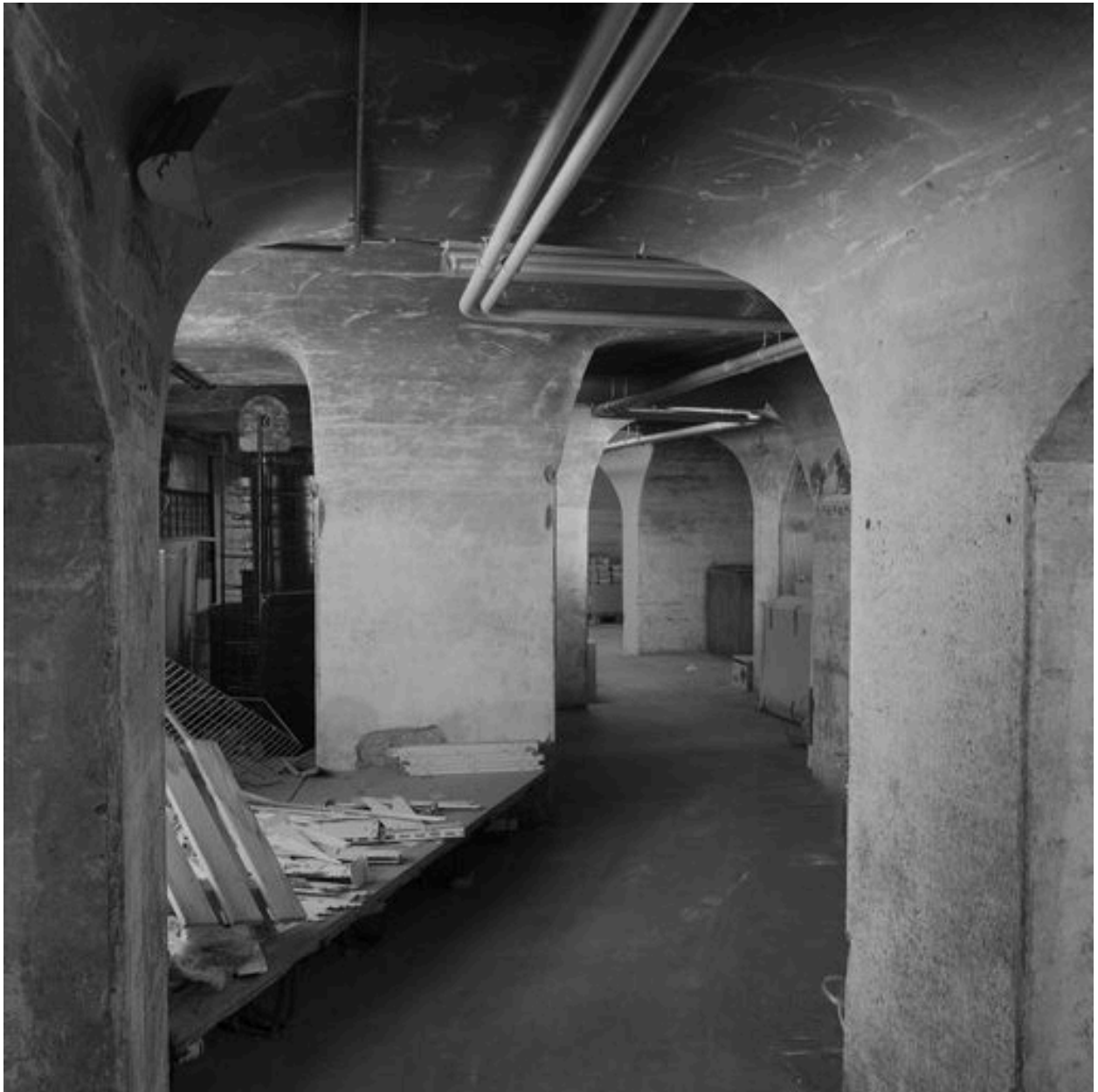
Sous-sol rue Tupin couloir central nord-sud : vue des voûtes à lunettes
