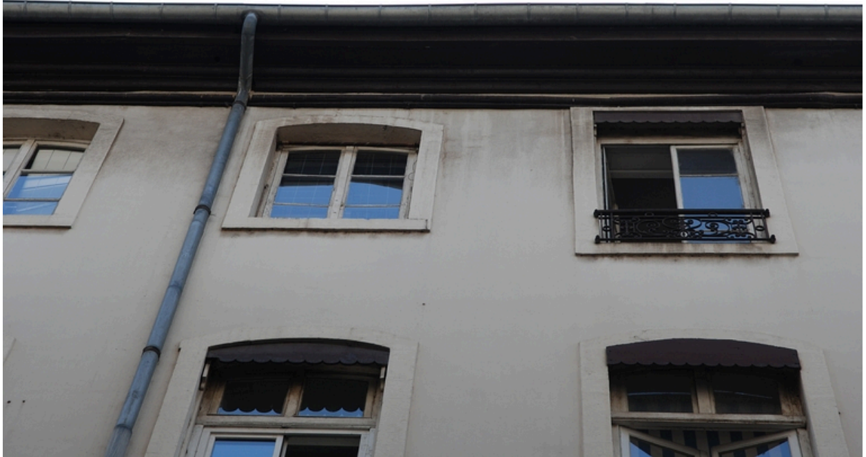
Elévation antérieure : fenêtres du dernier étage
