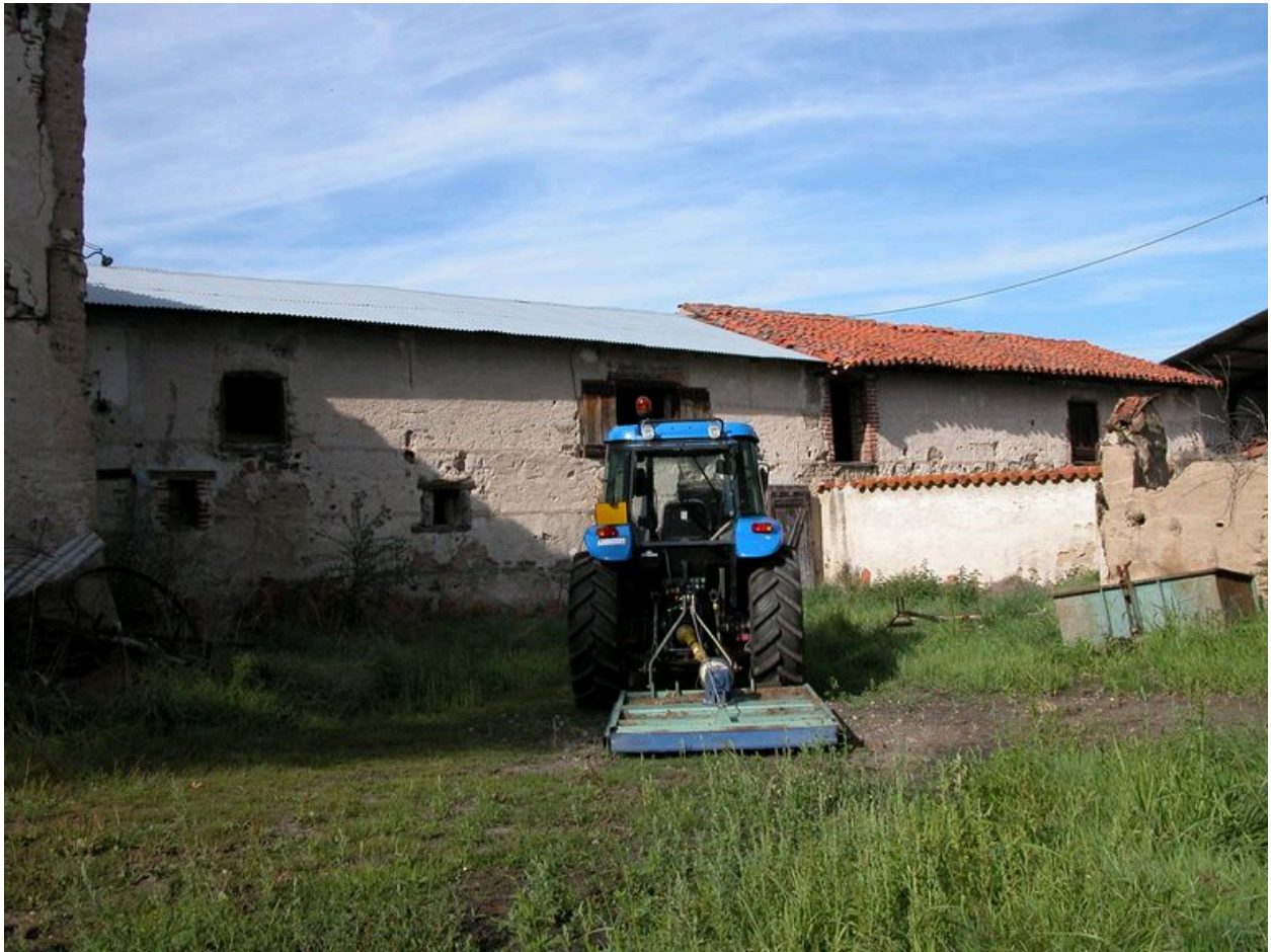
Vue des parties agricoles : bâtiment nord.
