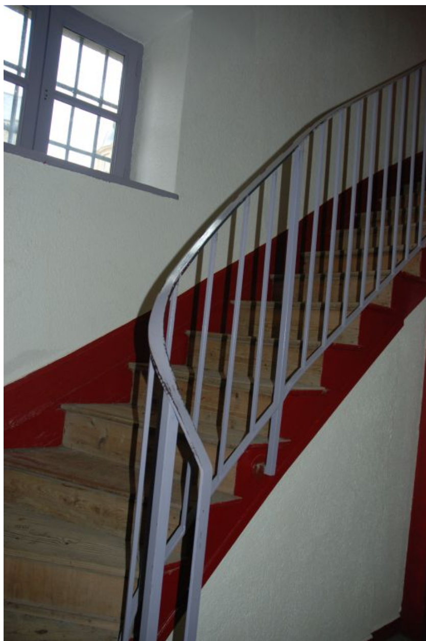
Départ de l'escalier secondaire logé dans l'aile nord-est du bâtiment, 19e siècle.
