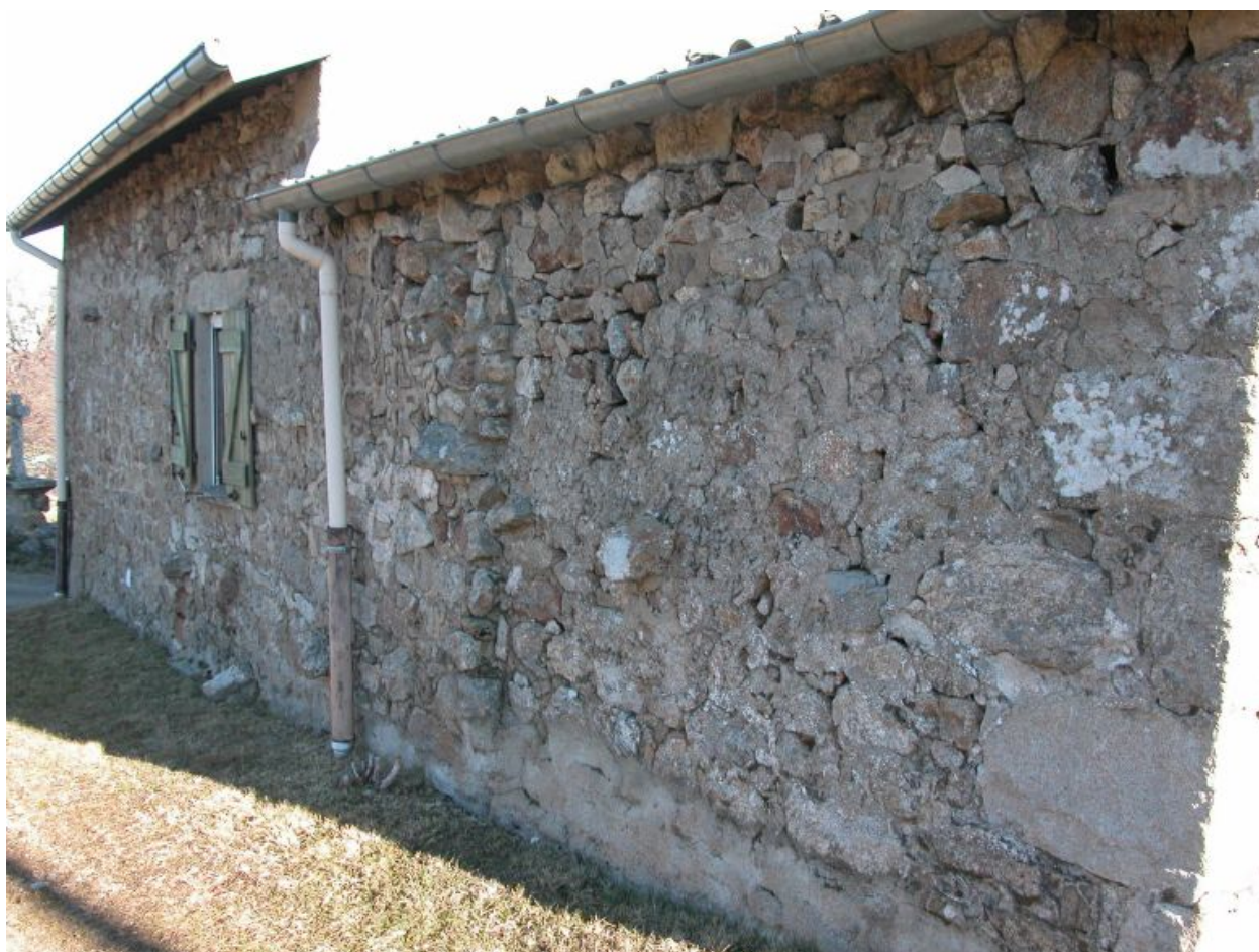
Elévation arrière (ouest) du logis.
