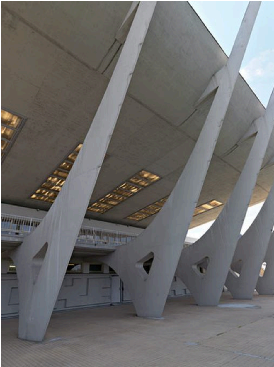
Détail du soubassement du bâtiment d'exploitation (état juin 2012).
