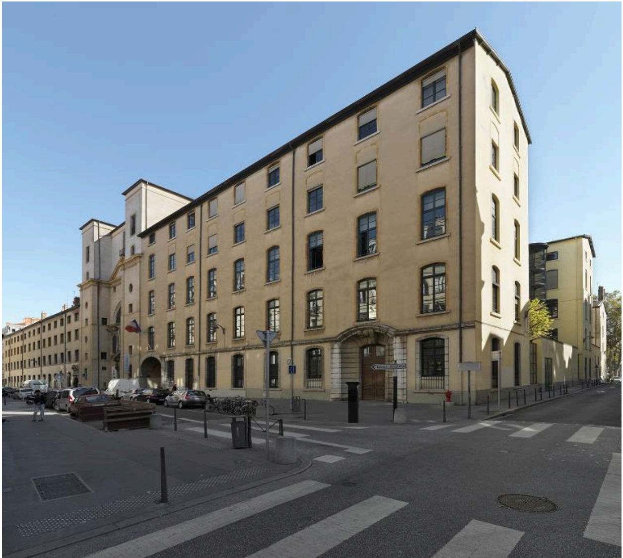
Vue générale depuis le sud-ouest
