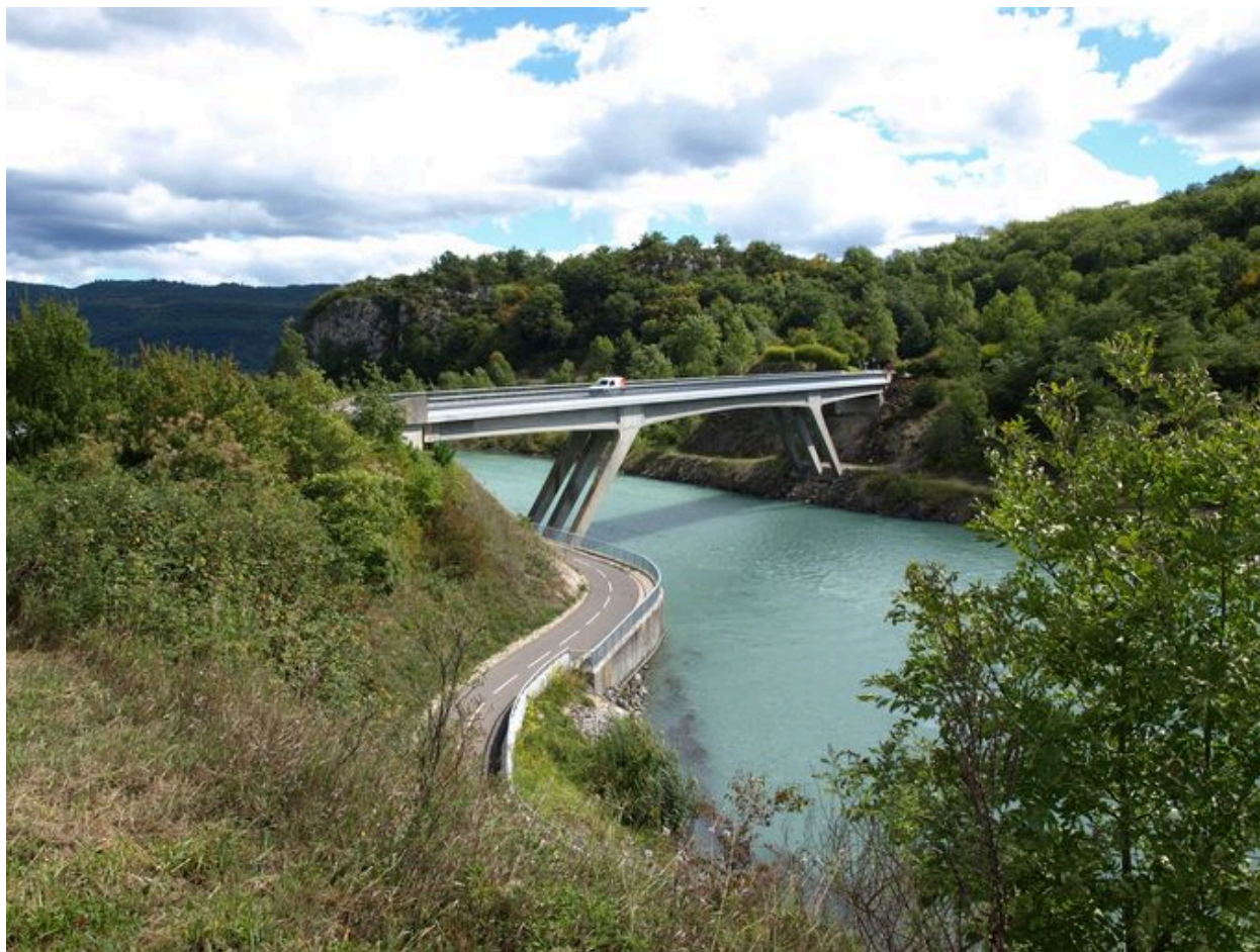
Vue du pont routier dit du Lit au Roi entre Cressin-Rochefort et Massignieu-de-Rives (Ain) ; pont poutre à béquilles (1981)
