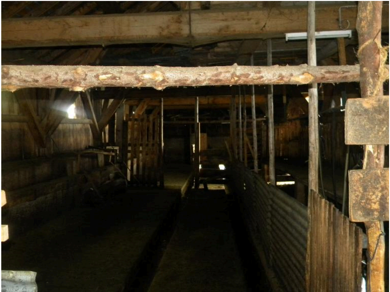
Vue de l'intérieur de l'étable.
