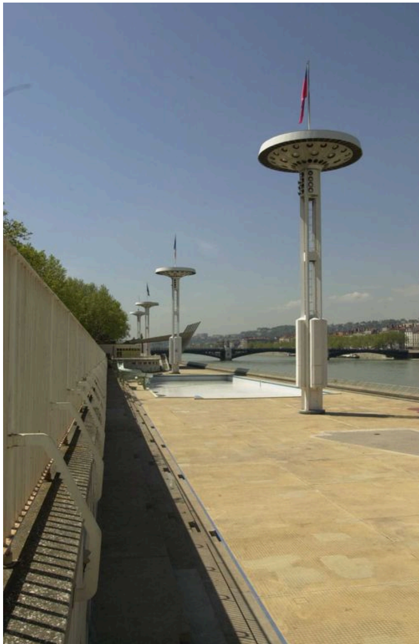
Vue d'un mât d'éclairage et du bassin nord
