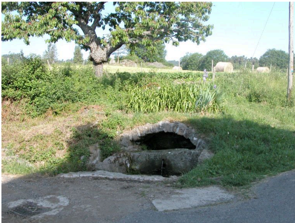
Conol (1986 AC 261), Fontaine, abreuvoir, vue d'ensemble.
