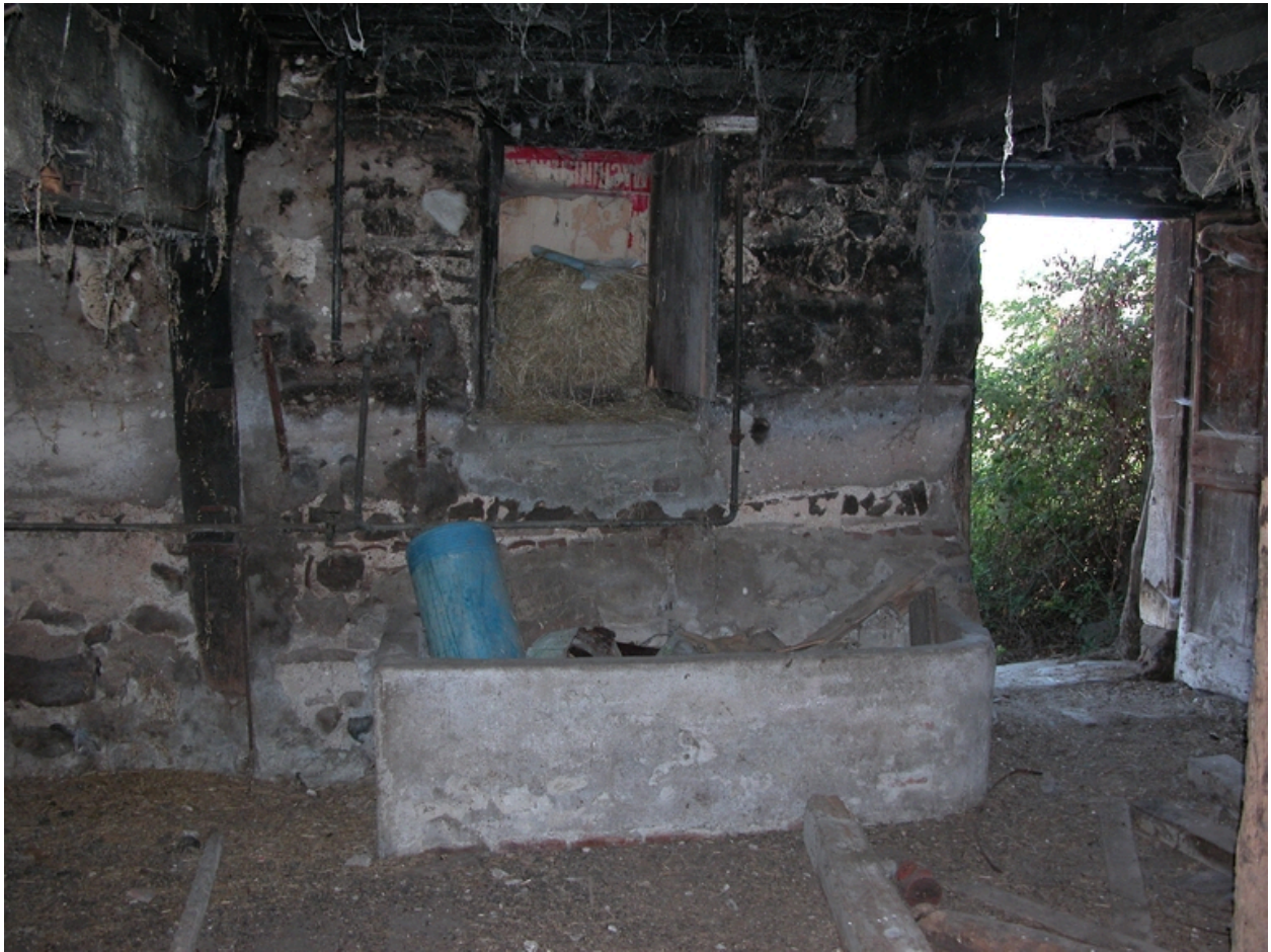
Vue intérieure du logis : laiterie (?).
