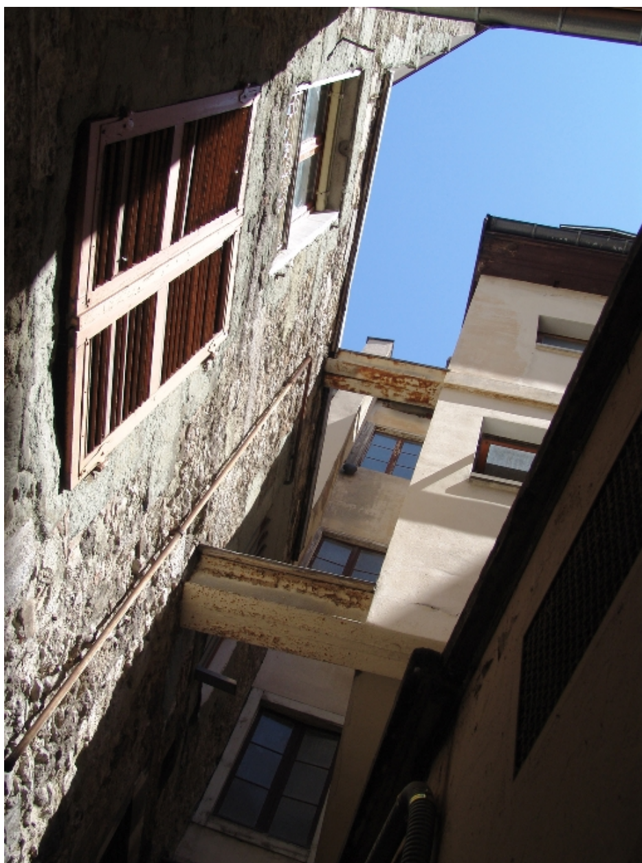
Courette intérieure vue depuis le bas
