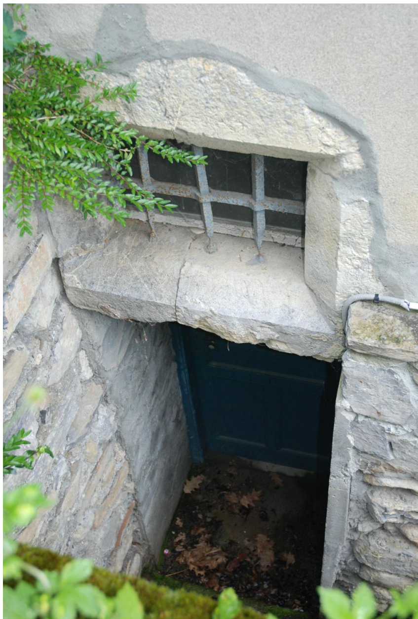
Demeure, porte extérieure de la cave (élévation est).
