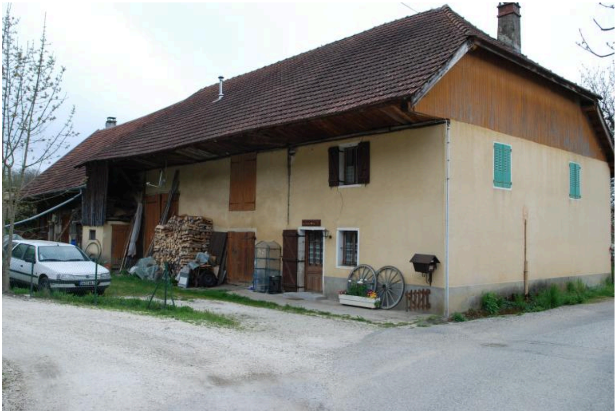
Vue d'ensemble de trois-quats avant droit de la ferme n° 506
