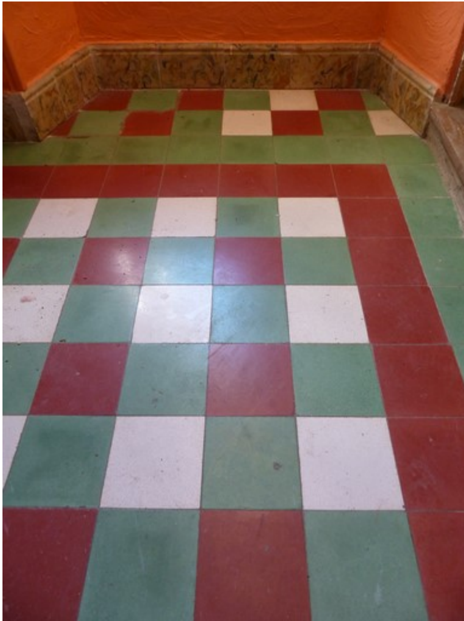
Rez-de-chaussée surélevé, chambre. Sol en carreaux de ciment.
