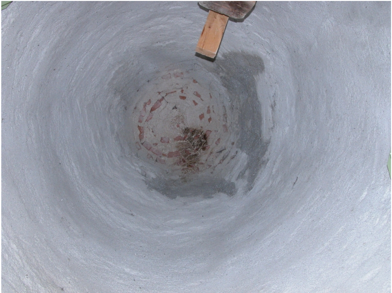
Vue intérieure d'une tourelle en surplomb : couverture.
