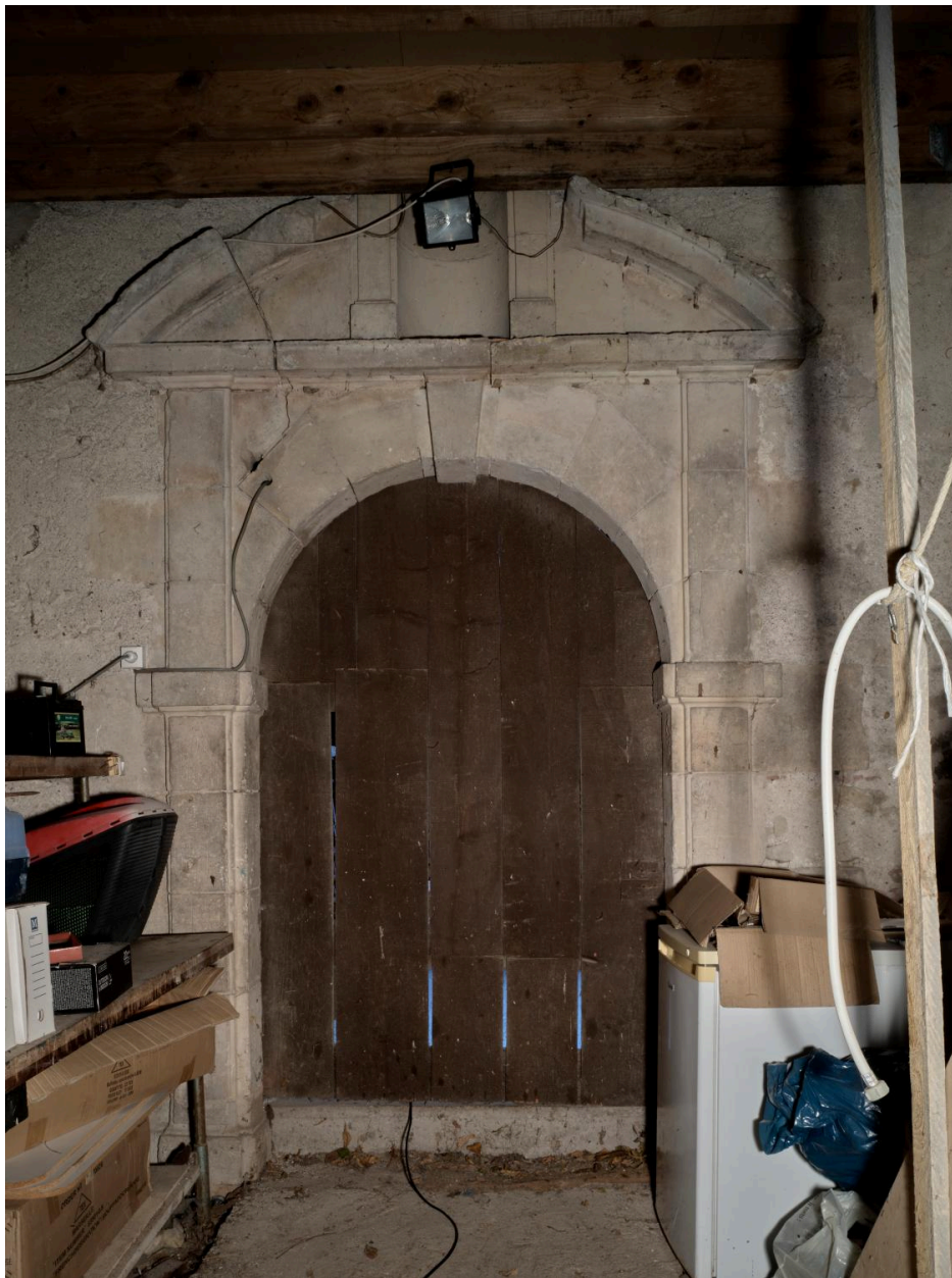
Porte extérieure de l'ancienne sacristie, à niche et linteau brisé, début du 17 e siècle, vue générale.
